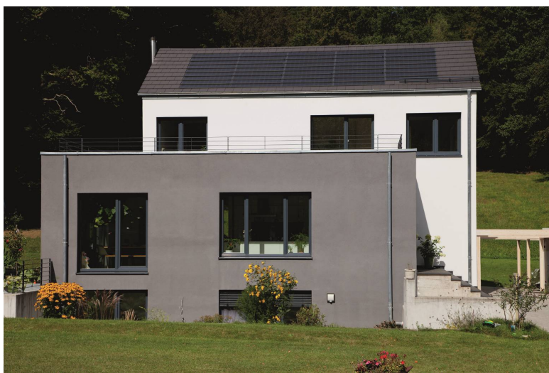
Foto 1 (Dach mit PV-Premium) Sonne domestiziert und doppelt gewonnen: PV Premium auf dem Dach.
